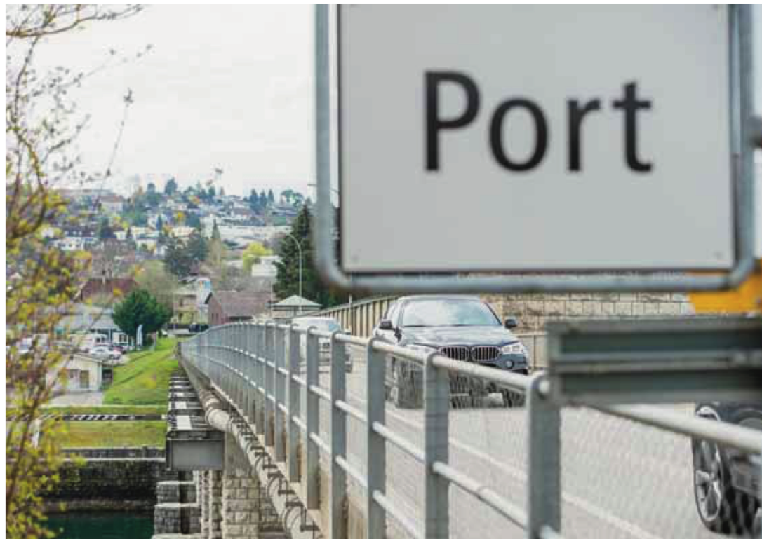
Der schlechte Zustand der Wehrbrücke dient als Argument für einen raschen Bau des Porttunnels. PS/JA
