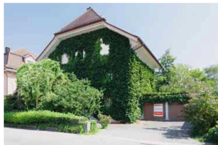
Ehemalige Direktorenvilla Dürig: Sie würde wegen des Westasts abgerissen. Schweren Herzens sind einige Bewohner schon ausgezogen.
